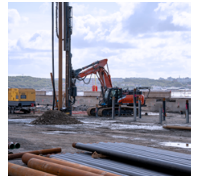
Pålningsarbete i Skandiahamnen för projekt Skandiaporten.
